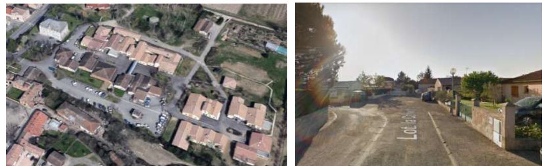
Figure 63 : Extensions de la seconde moitié du XXème siècle, source : Google Street View
